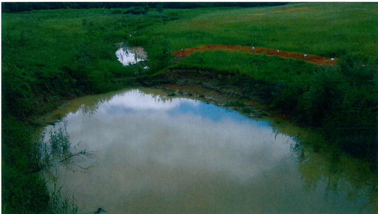
Figura 3 – Foto eseguita dal ponte della SP154 in data 14/05/19: ansa piena di acqua.
